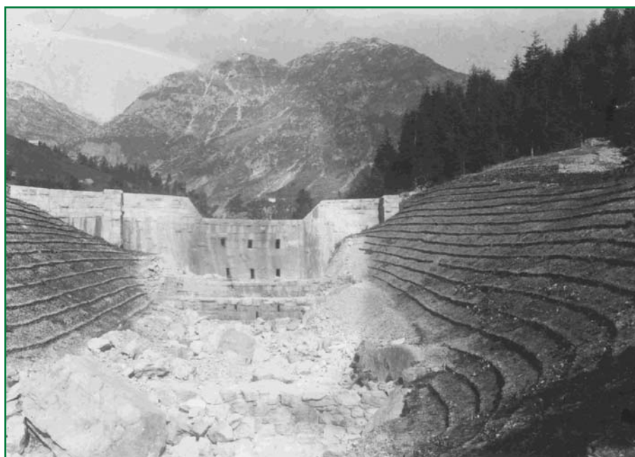
Briglia al ponte di Revolto con sistemazione delle scarpate laterali
